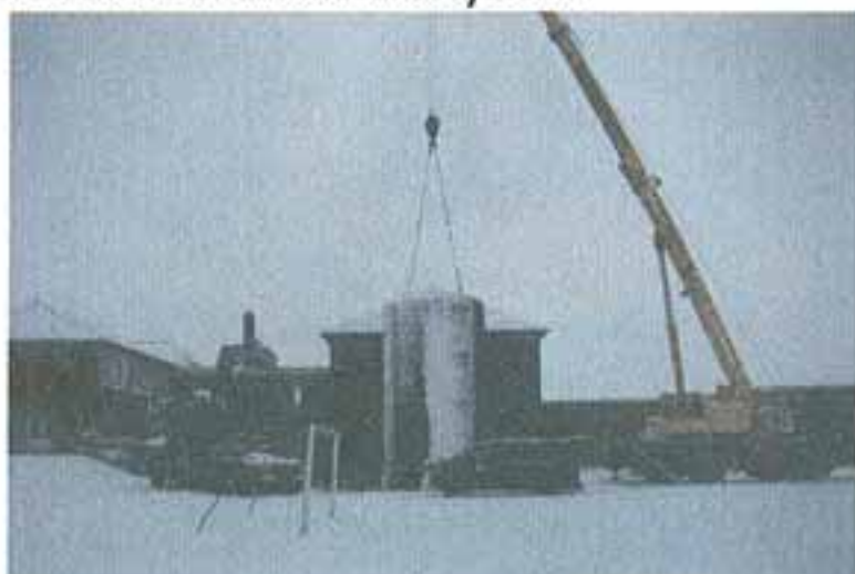
Akkumuleringstank kommer på plads.
